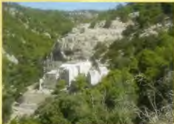
PUSTINJA BLACA - POGLED S PČELINJAKA
